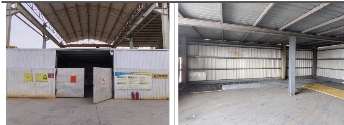
危废暂存间及标识
